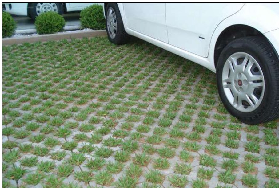
Figura 34: Exemplo de pavimento poroso (bloquetes vazados). Fonte: Inova Consultoria Ambiental
