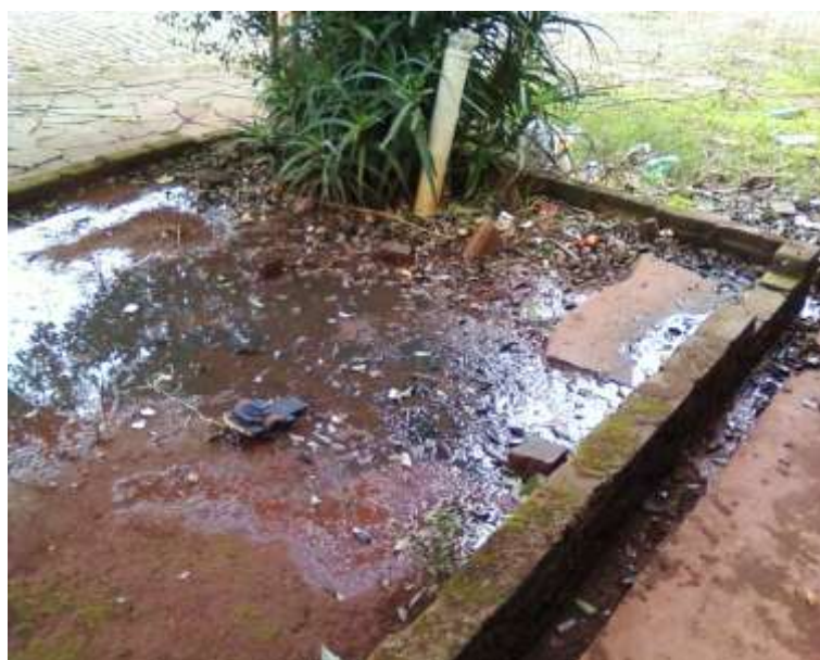
Imagem de poço negro saturado com líquidos contaminados transbordando para a superfície Fonte: Prefeitura Municipal de Selbach
