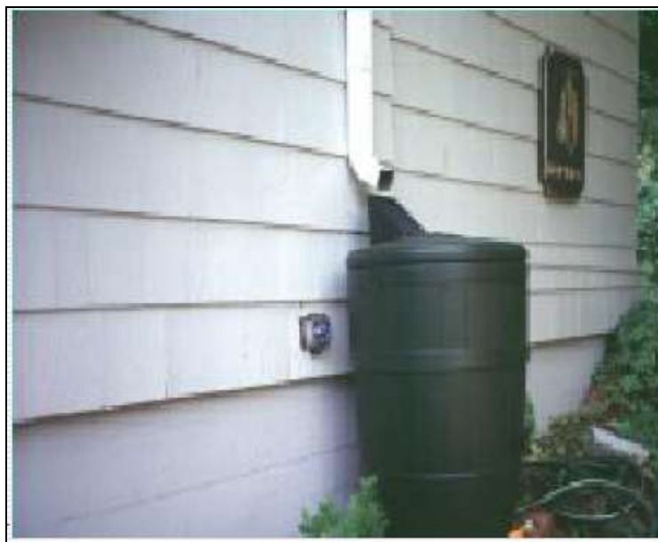
Figura 38: Exemplo de cisterna instalada em uma residência. Fonte: Inova Consultoria Ambiental
