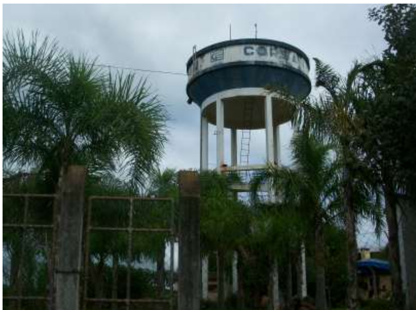
Imagem 93: Reservatório Elevado Saída Colorado – Concreto (R 3) capacidade 50.000 litros Fonte: Prefeitura Municipal de Selbach
