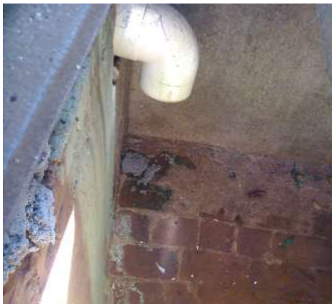
Imagem 97: Imagem de ligação do poço negro à rede pluvial. Fonte: Prefeitura Municipal de Selbach
