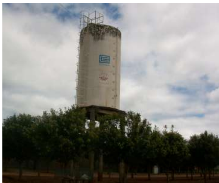
Imagem 92: Reservatório Elevado Saída Colorado – Concreto (R 3) capacidade 50.000 litros Fonte: Prefeitura Municipal de Selbach
