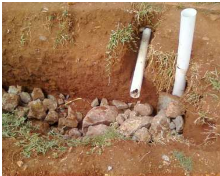
Imagem 96- Imagem da forma construtiva do poço negro. Fonte: Prefeitura Municipal de Selbach
