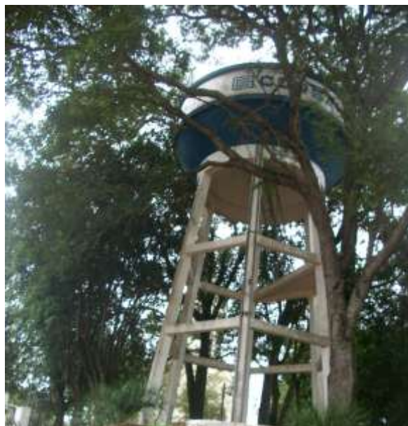
Imagem 91: Reservatório Elevado Vila Sefrin – Metálico (R 2) capacidade 50.000 litros. Fonte: Prefeitura Municipal de Selbach
