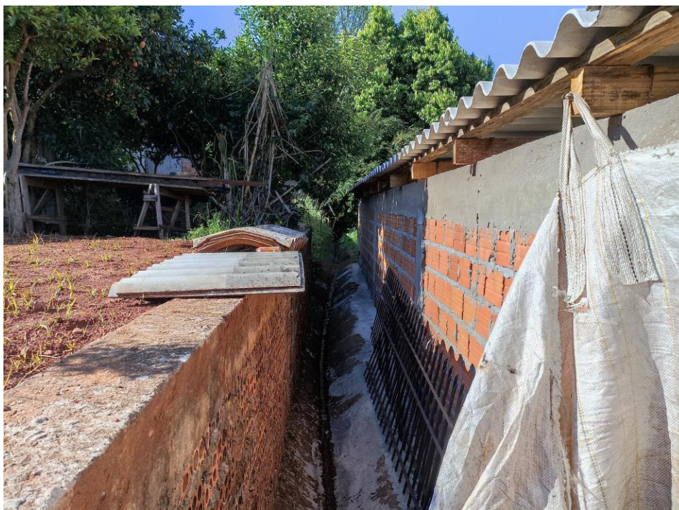
Figura 5 – Canal de drenagem pluvial também usado para escoamento de esgoto.
